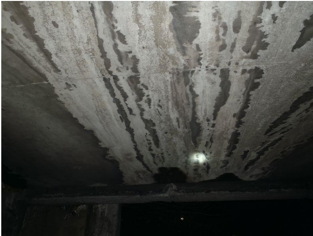
Photo 3. : Travée C0-P1, traces de ruissellement et calcite active sur l'encorbellement
