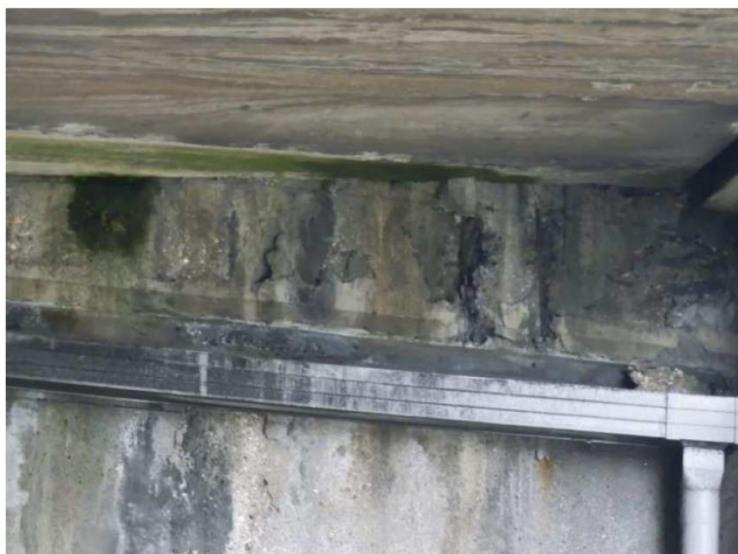
Eclat de béton de la culée C0
