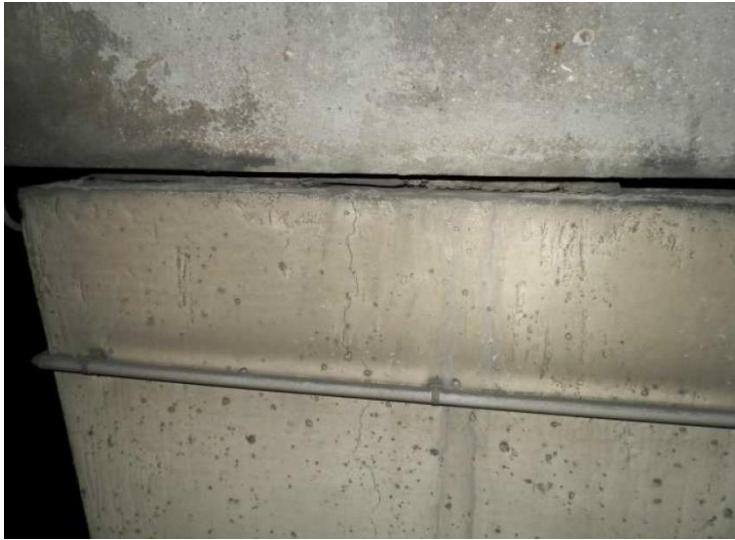
Fissuration des chevêtres de pile
