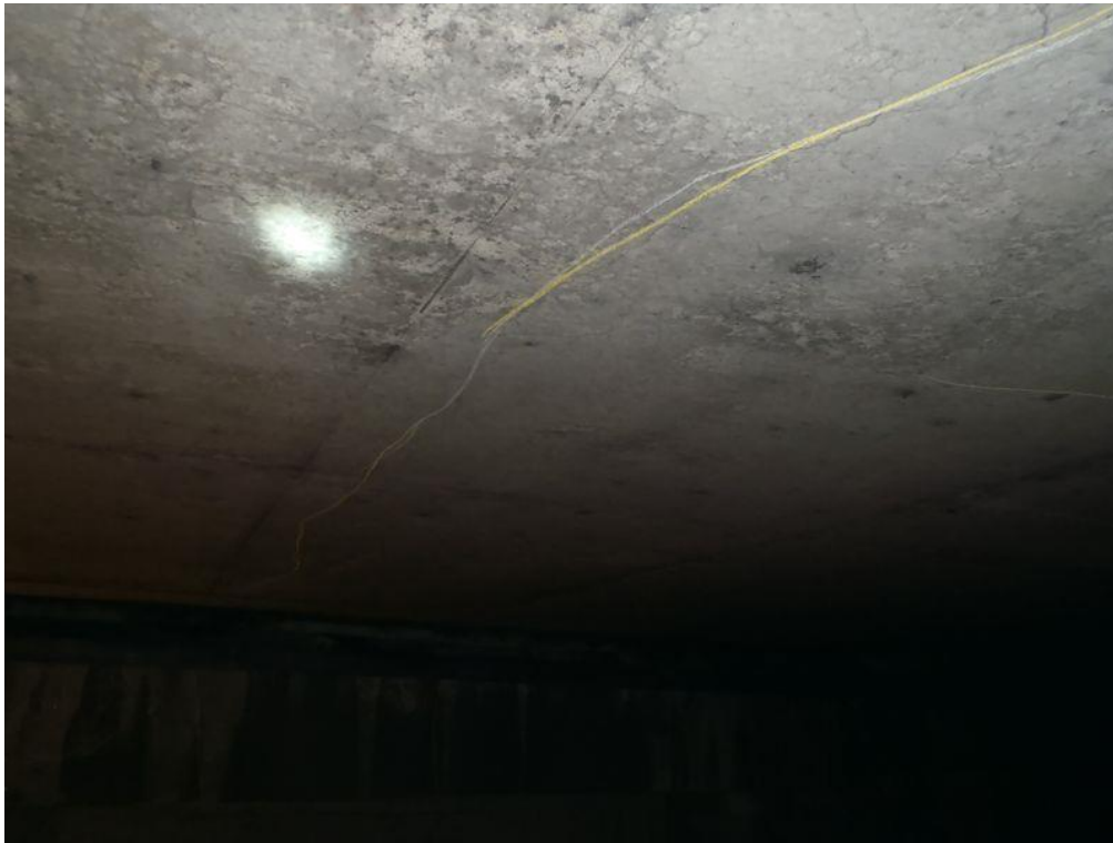
Photo 11. : Travée C0-P1, fissuration longitudinale
