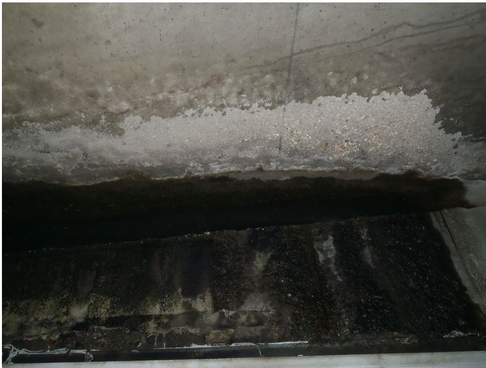
Photo 10. : Humidité sur l'extrémité du tablier côté C4.
