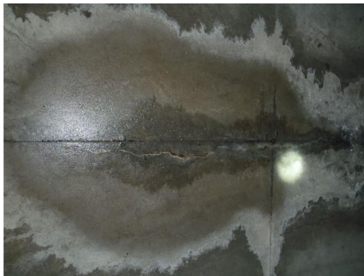
Fissuration longitudinale de la dalle
