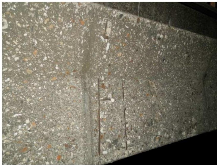
Eclat de béton des corniches
