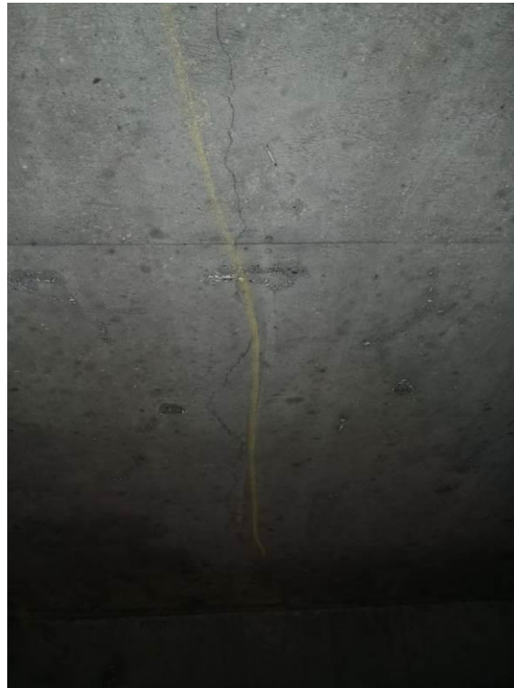
Photo 15. : Travée P3-C0, fissuration longitudinale
