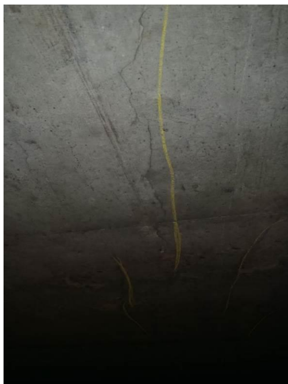
Photo 14. : Travée P3-C0, fissuration longitudinale
