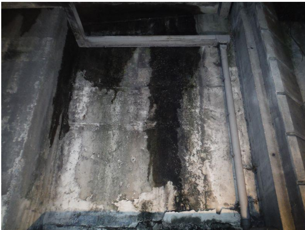
Photo 22. : Culée C4, arrivée d'eau sur le sommier et traces noirâtre
