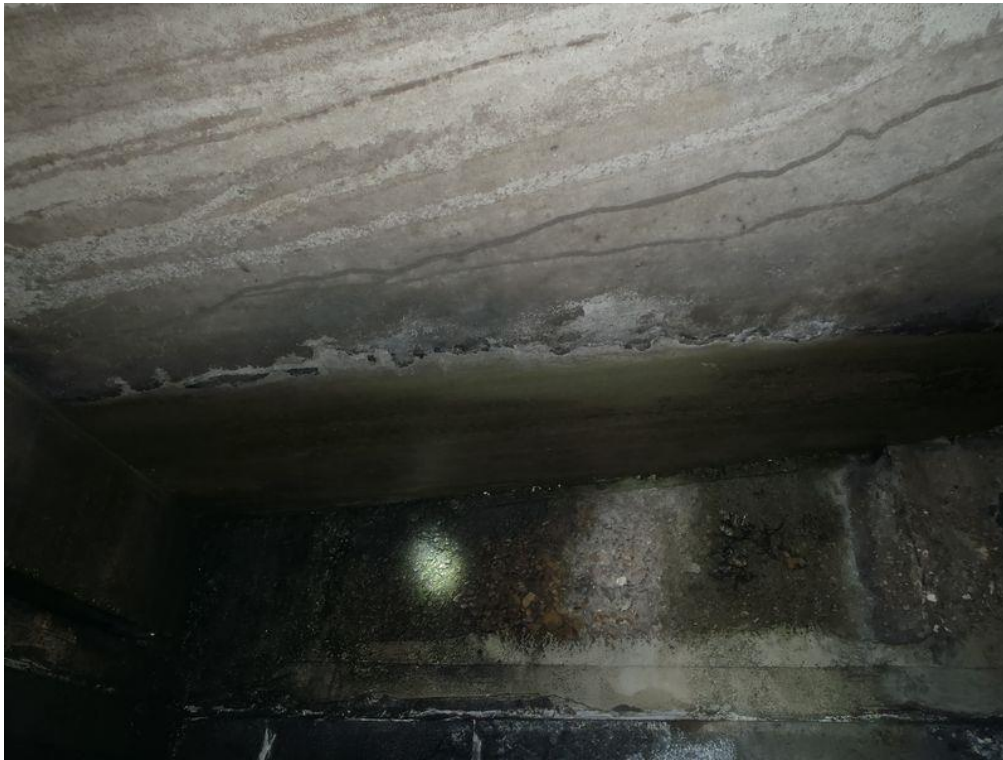
Photo 9. : Humidité sur l'extrémité du tablier côté C0.
