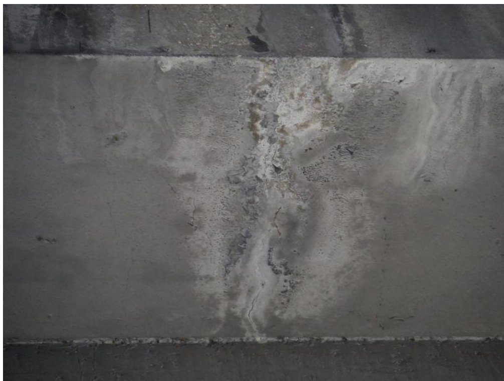
Photo 25. : Culée C0, fissuration verticale sur le chevêtre
