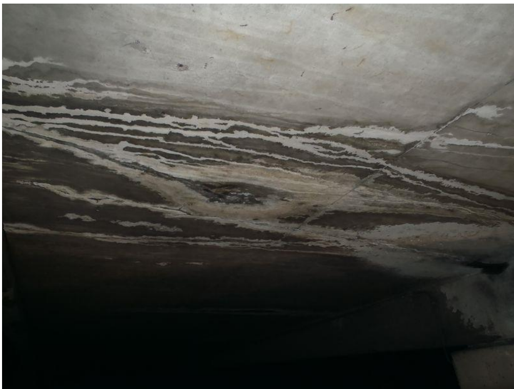
Photo 4. : Travée P3-C4, traces de ruissellement et calcite active sur l'encorbellement
