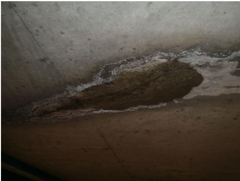
Photo 8. : Travée P3-C4, infiltration d'eau au travers de la dalle, fissuration, présence de calcites humides
