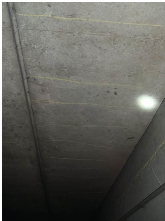
Photo 16. : Travée C0-P1, fissuration transversale sur encorbellement
