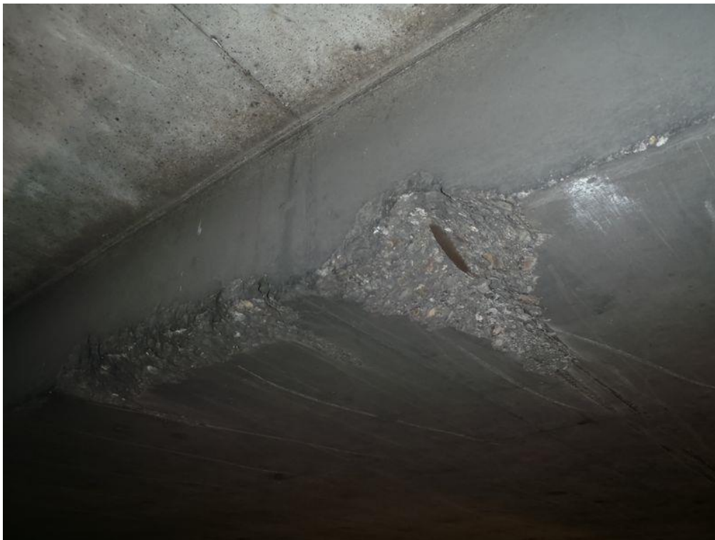
Photo 20. : Travée P3-C0, trace de frottement avec éclat
