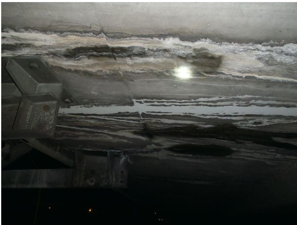
Photo 6. : Travée C0-P1, infiltration d'eau au travers de la dalle, fissuration longitudinale, présence de calcites humides
