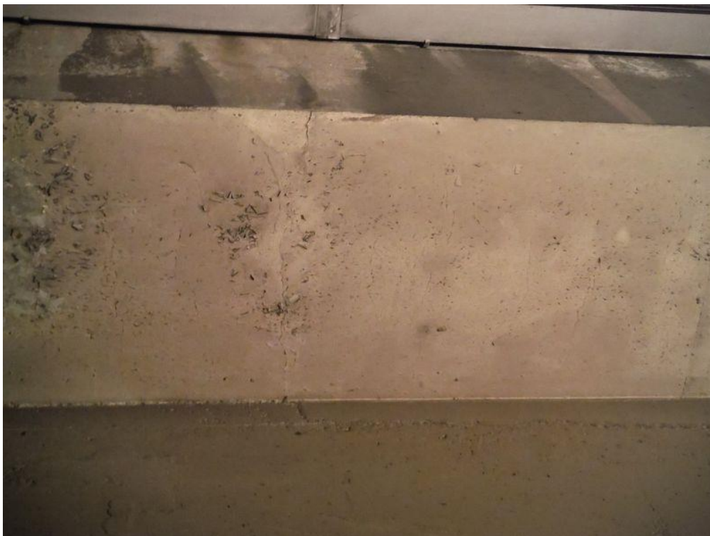
Photo 24. : Culée C0, fissuration verticale sur le chevêtre
