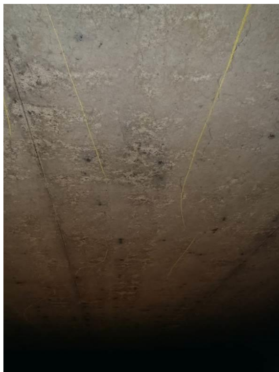
Photo 13. : Travée C0-P1, fissuration longitudinale
