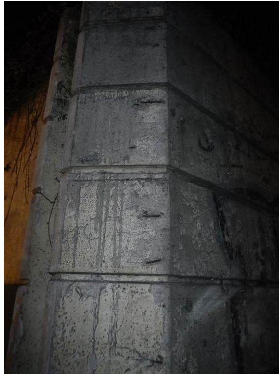
Photo 29. : Culée C4, éclats avec aciers apparents
