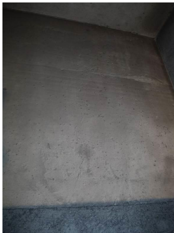
Photo 28. : Culée C4, fissuration verticale sur le mur front
