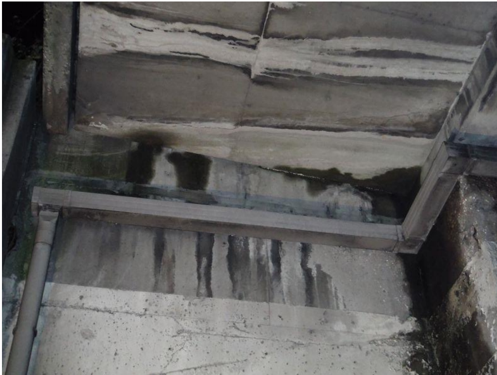
Photo 21. : Culée C0, arrivée d'eau sur le sommier et traces noirâtre
