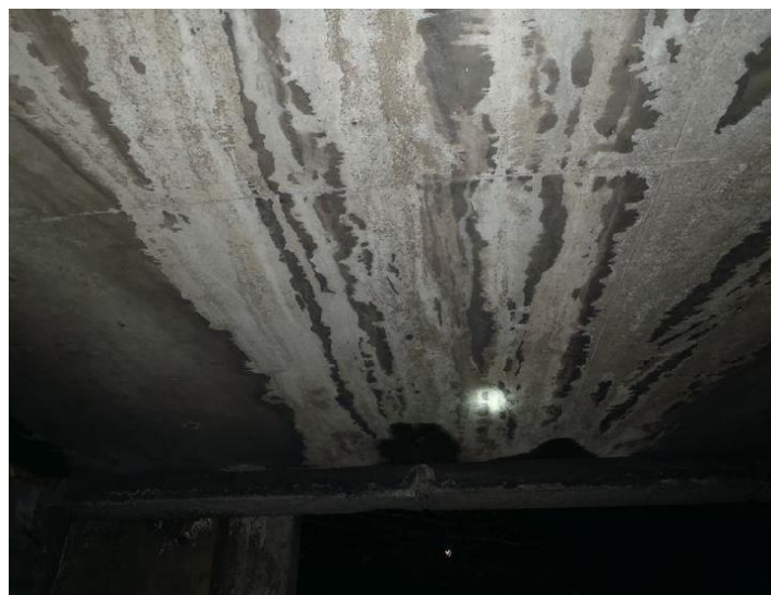
Ruissellement sous encorbellement
