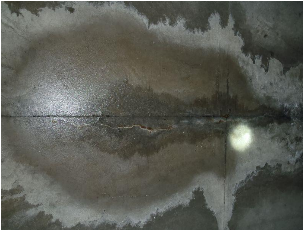
Photo 5. : Travée C0-P1, infiltration d'eau au travers de la dalle, fissuration longitudinale
