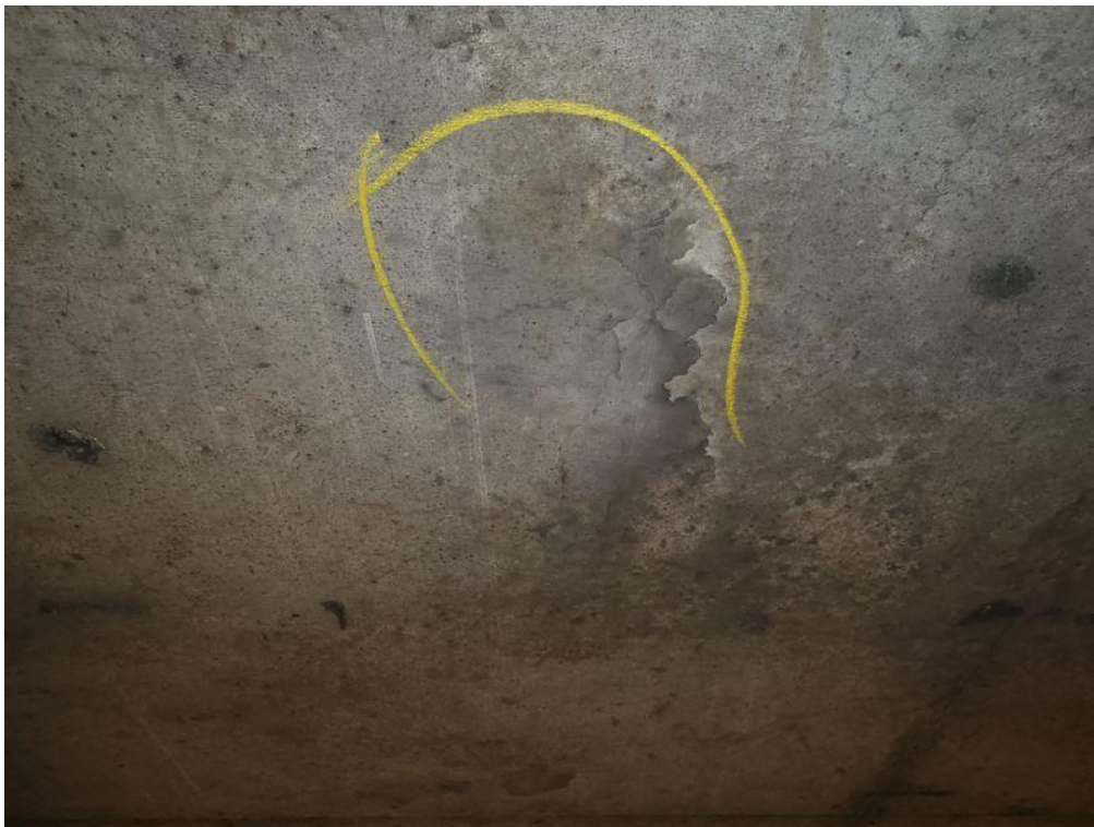
Photo 18. : Travée P3-C0, éclat en formation
