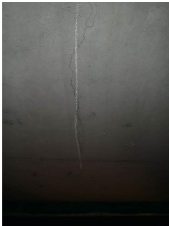
Photo 12. : Travée C0-P1, fissuration longitudinale
