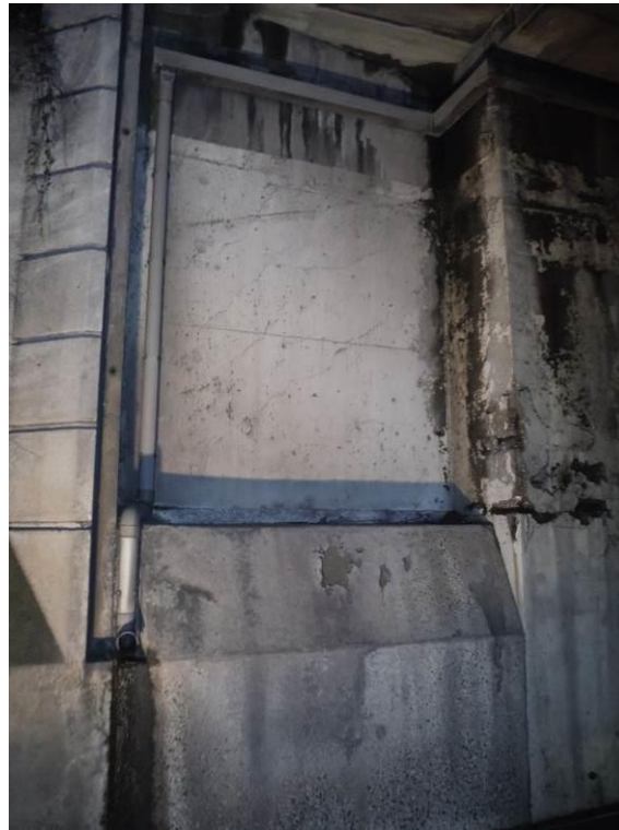
Photo 23. : Culée C0, fissuration verticale sur le mur front
