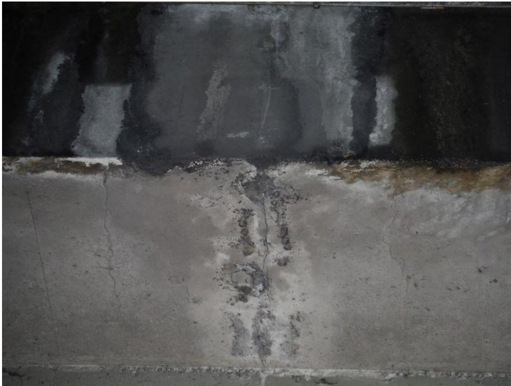
Photo 27. : Culée C4, fissuration verticale sur le chevêtre
