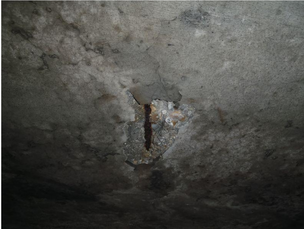
Photo 19. : Travée P3-C0, éclat avec acier apparent corrodé
