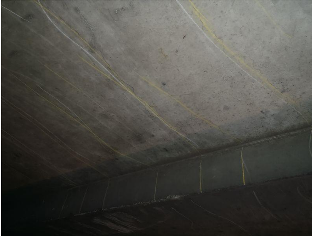
Photo 17. : Travée P3-C0, fissuration transversale sur encorbellement
