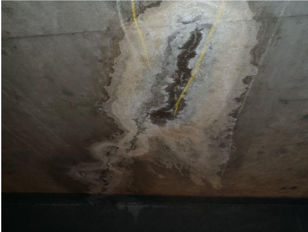
Photo 7. : Travée P3-C4, infiltration d'eau au travers de la dalle, fissuration, présence de calcites humides
